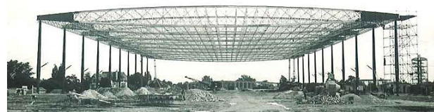
Figure 5: Halle métallique composé de poutres treillis
